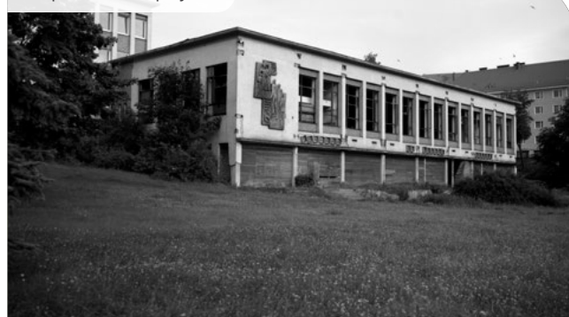
Stav před realizací projektu
