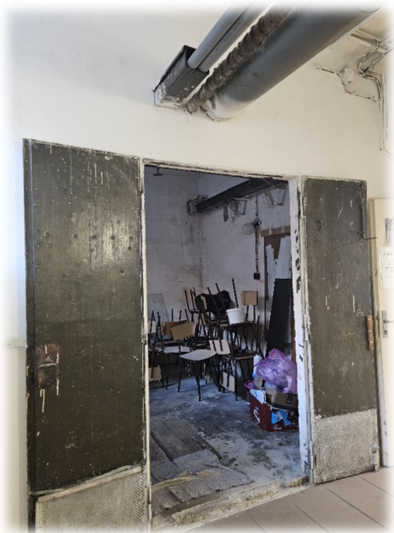
5. Obrázek – Pohled do nynějšího skladu zprava
