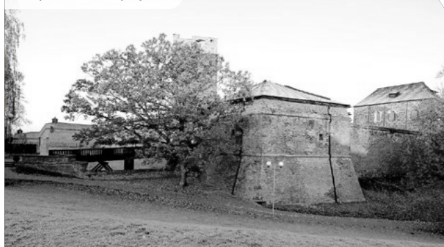
Stav před realizací projektu
