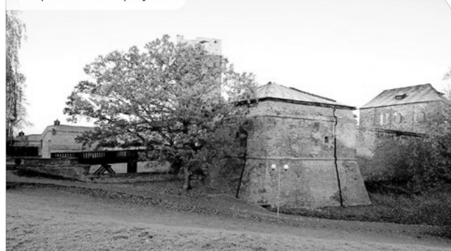
Stav před realizací projektu
