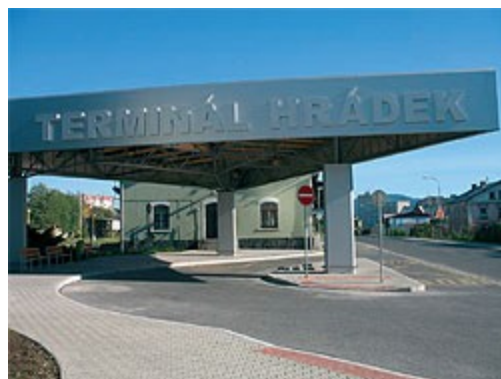
Nově vybudovaný terminál přehraniční veřejné dopravy v Hrádku nad Nisou
