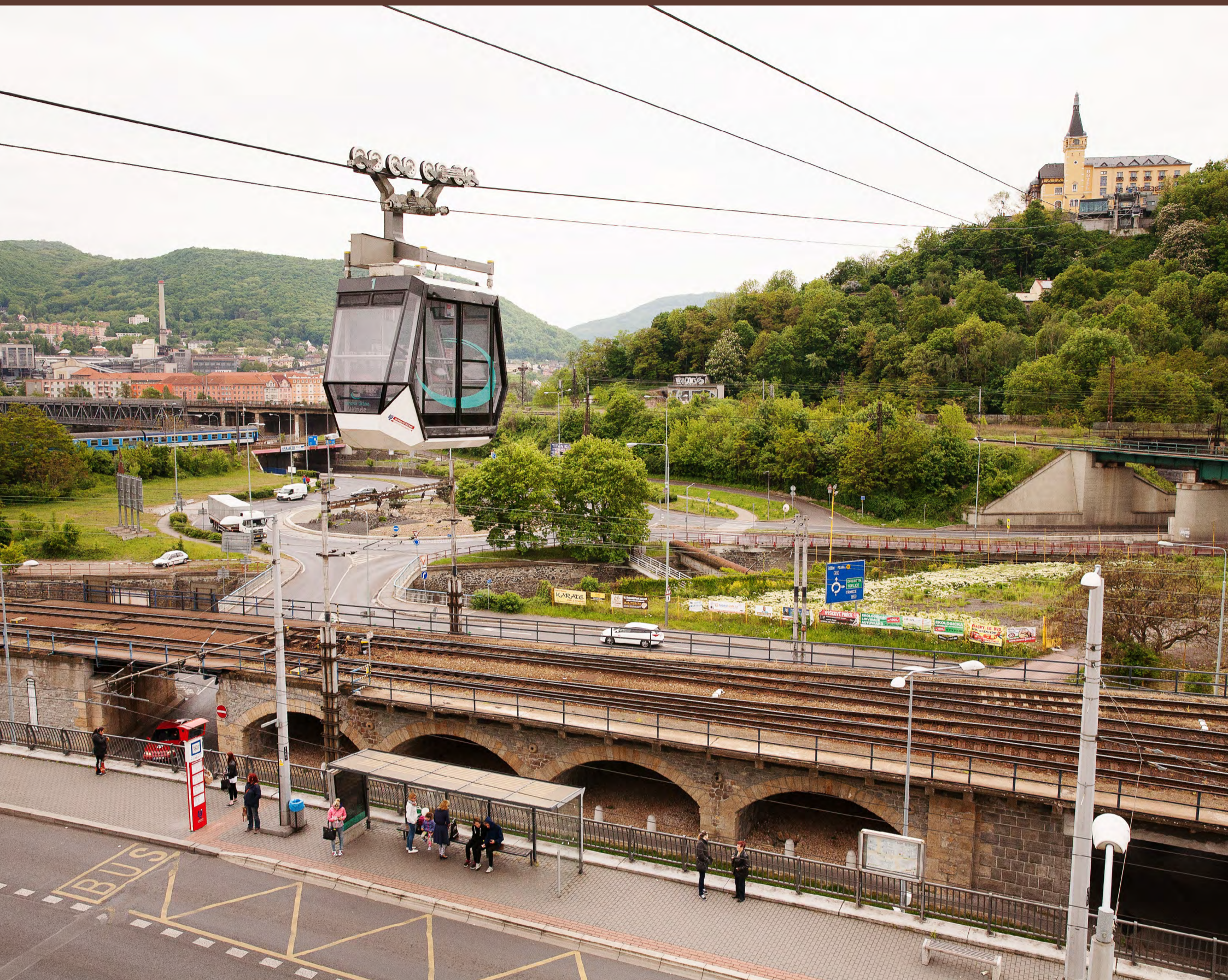
Lanová dráha na Větruší
