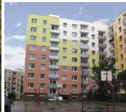
Stavební úpravy bytového domu Bílá 1961–1962
