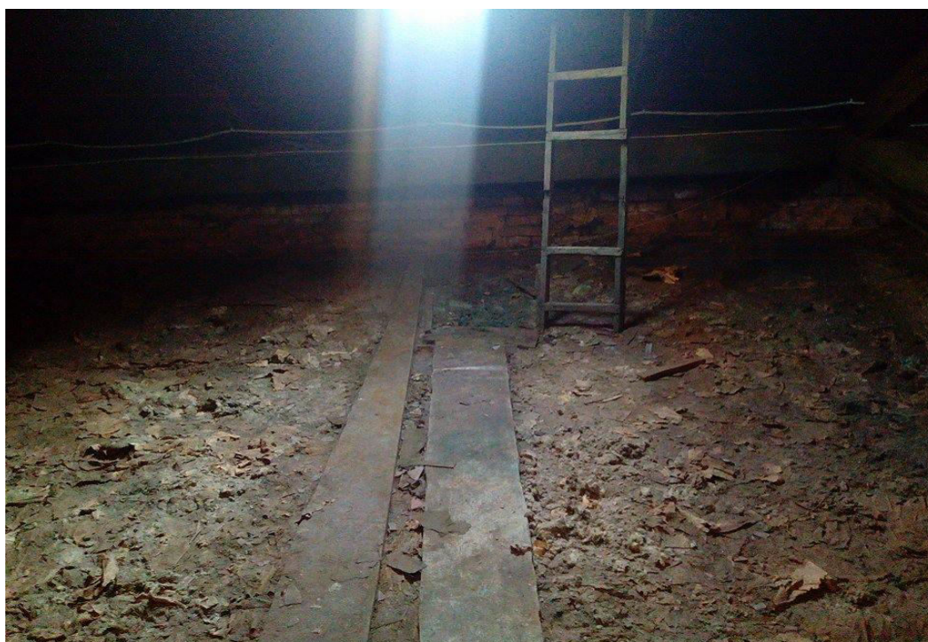
Stropní zateplení je v nevyhovujícím stavu. Doplnění bude provedeno foukanou izolací.
