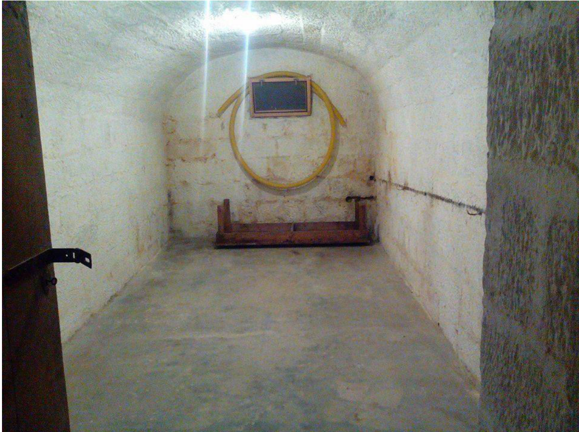
Budova je částečně podsklepená a nemá izolaci proti zemní vlhkosti.
