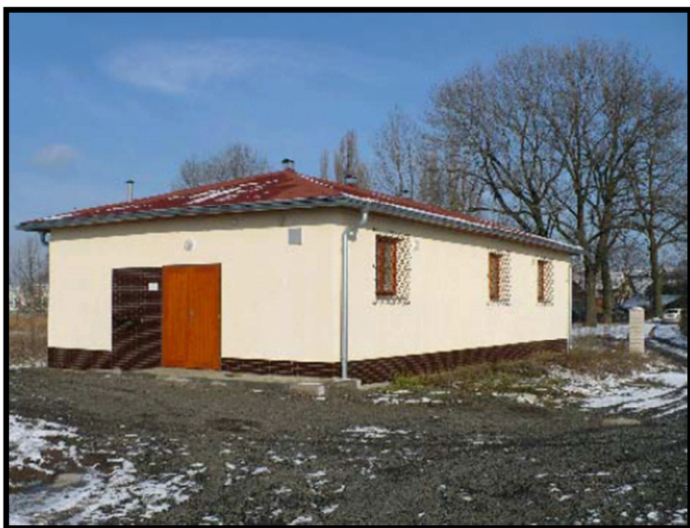
Foto 4 – zasazení ČOV do terénu (poskytnuto se souhlasem firmy Fortex AGS Šumperk a. s.)
