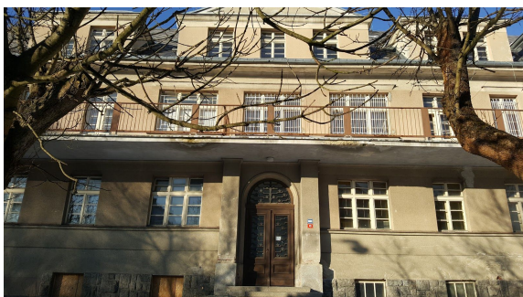
čelní pohled na hlavní vchod
