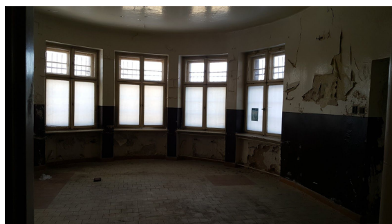
výklenek budovy v přízemí
